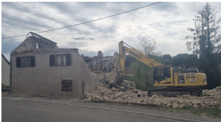
Le presbytère de Burbach, en cours de démolition ( DNA , cliché Julien Meyer)
