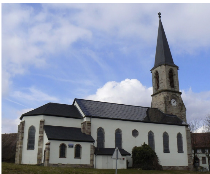
Les panneaux solaires de l'église de Manspach (source : https://www.manspach.fr/patrimoine/eglise-saint-leger.htm )
