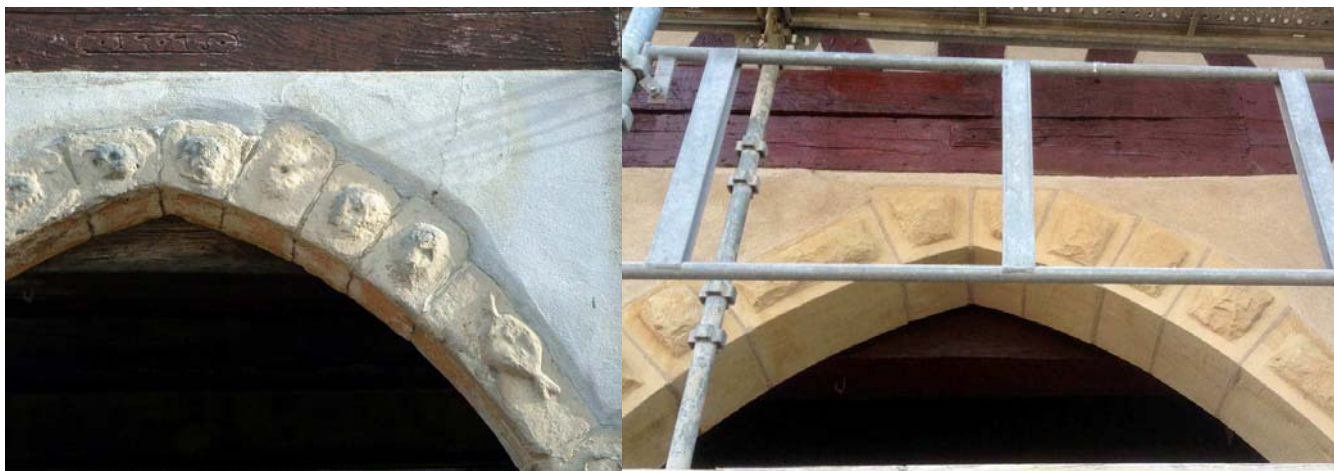
L'arc brisé de la porte avant et après les travaux de « restauration » (clichés : D. Tomasini)
