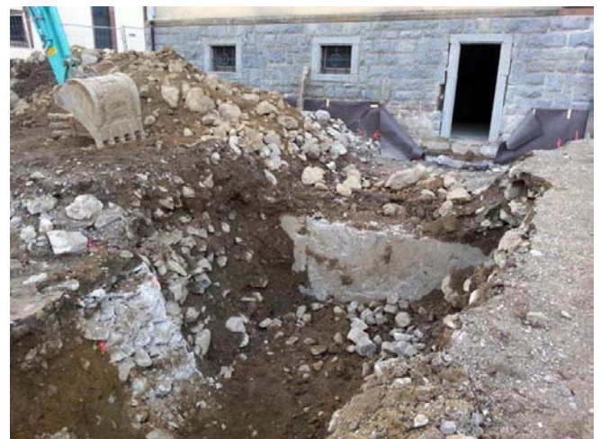
Découverte des aménagements bétonnés de l'ambulance alpine avant leur destruction (photo : Communauté de communes de la vallée de Munster)
