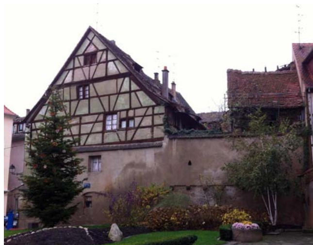
Vue depuis la place du Docteur Kubler des immeubles menacés de démolition dans le cadre du projet d'extension de la Bibliothèque Humaniste
