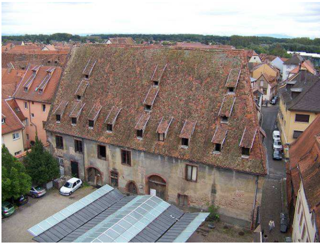
Vue de l'arsenal Saint-Hilaire avant les travaux de 2012/13
