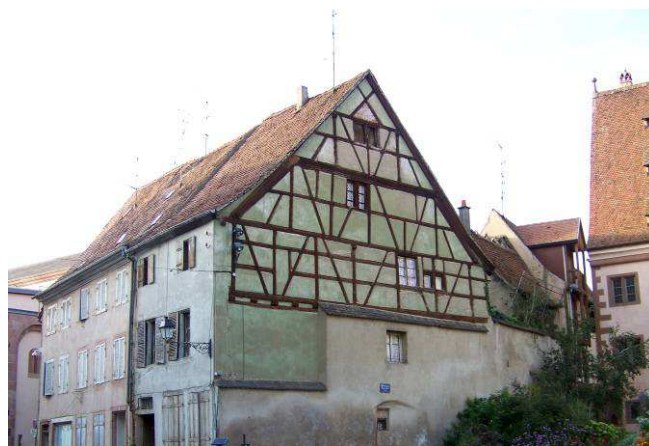
Vue des immeubles menacés de démolition dans le cadre du projet d'extension de la Bibliothèque Humaniste
